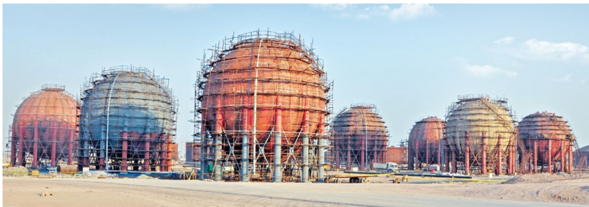
مخازن کروی پالایشگاه ستاره خلیج فارس در مراحل میانی ساخت Persian Gulf Star Oil Refinery spherical tanks at the middle of project
