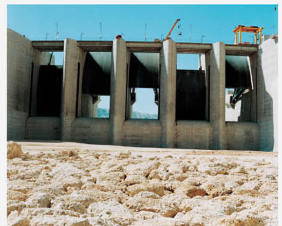
دریچه های قطاعی سد و نیروگاه آبی مسجد سلیمان
