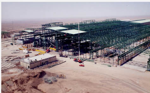
اسکلت فلزی فولاد آلیاژی یزد
